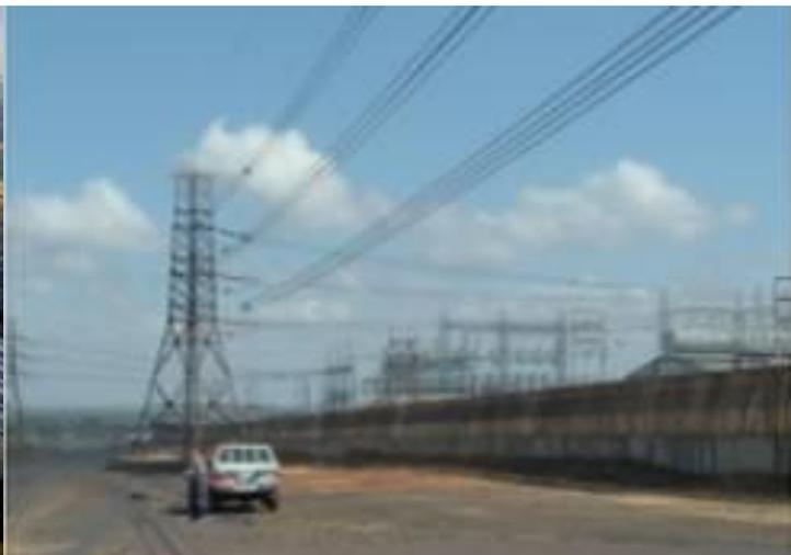
**Descripción:** Ampliación y nuevo sistemas eléctricos que alimentan la V Línea en CVG Venalum. Líneas de transmisión 115 kV para interconexión sistema existente nuevas facilidades
